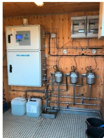
Abbildung 1: Hach BioTector Online-TOC-Messung im Zulauf.
