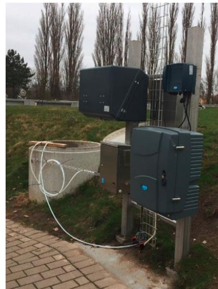
Abbildung 2: Hach Amtax sc Ammonium-Analysator, Nitratax sc Nitrat-Sensor und SC1000 Controller.
